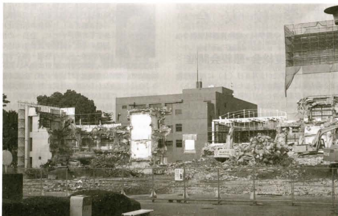
中央は現在の本館。右側の建築中の建物は新館実験実習棟。解体中の建物は5号館、第3講義室学生ホール
