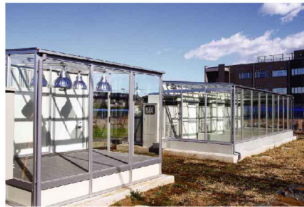
学科研究圃場に新設された組換え温室
