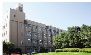
平成19年に改修した6号館
