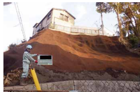
住宅地内でののり面緑化工完成記録写真
