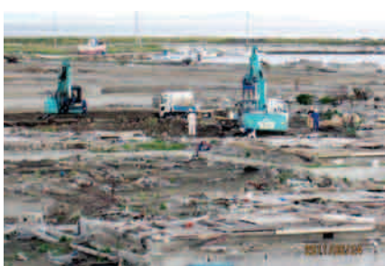
〈瓦礫処理が進む名取市関上地区〉
