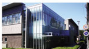
平成18年に竣工した9号館(臨床棟)
