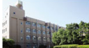
平成19年に改修した6号館
