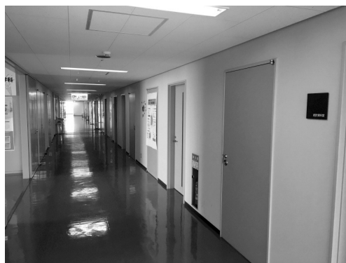
写真1 閑散としていた本館10階廊下
