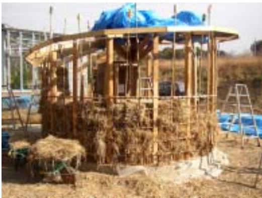
写真 17 日大アトムハウスのストローベイルの積載中。構造の柱は津久井町の間伐材を活用。
