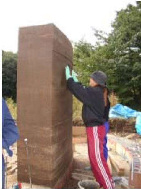
写真 2 2 型枠をはずした状態 土の様子が美しい。
