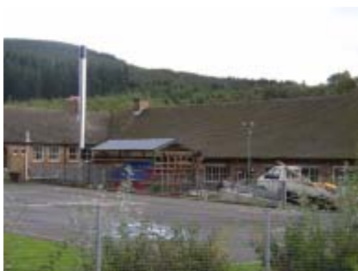
写真5 小学校に設置された地域暖房のチップボイラー施設
