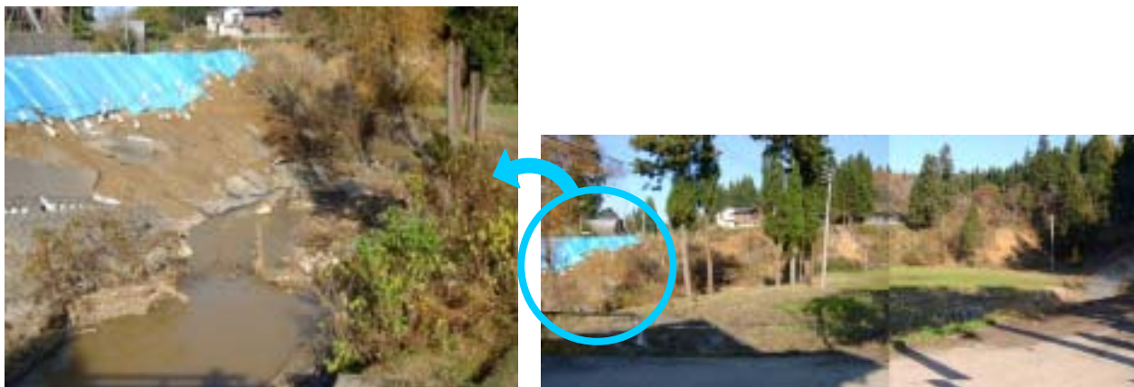
相川川に一部が崩落した県道(11月23日)
