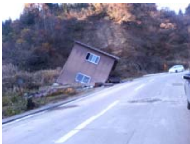
座屈して傾いた農機具庫（11月23日）
