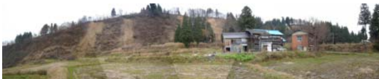
二子部落の斜面崩壊の様子(12月4日)
